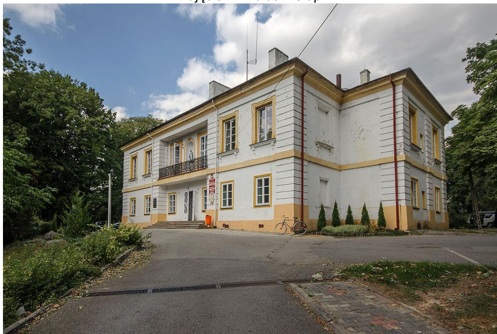
Zdjęcie 21: Pałac w Słupi
